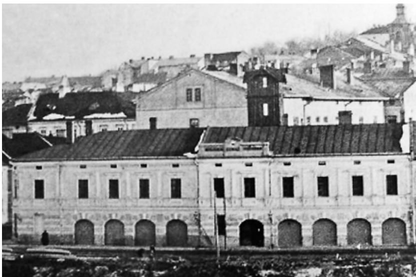
Budynek Miejskiej Straży Pożarnej w Przemyślu przy ul. Wodnej 13, widok na bramy wyjazdowe od strony ulicy Jagiellońskiej. Z tyłu budynku widoczna drewniana wieża – wspinalnica do ćwiczeń. Widok z września 1939 r.
