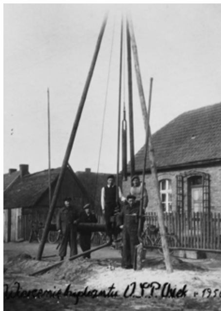
Fot. 4. Druhowie z OSP Osiek nad Notecią budują studnię na potrzeby własnej OSP oraz mieszkańców. 25.04.1956 r. Kronika Ochotniczej Straży Pożarnej w Osieku nad Notecią 1909-30.08.2012, kronikarze Wojciech Królak i Magdalena Królak.
